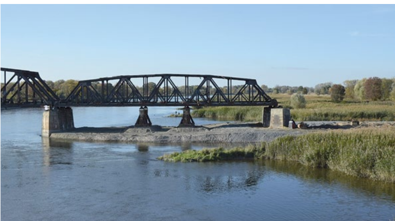
Ostbahnbrücke bei Küstrin-Kietz
