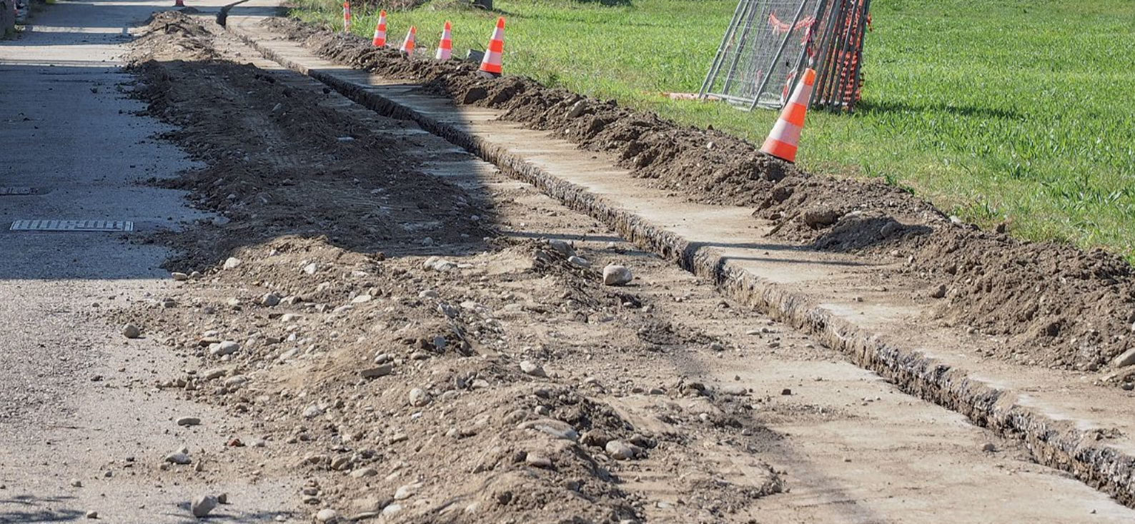
Verlegung von Glasfaserkabel
